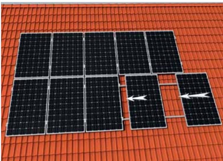
18 - Suite des opérations de montage
