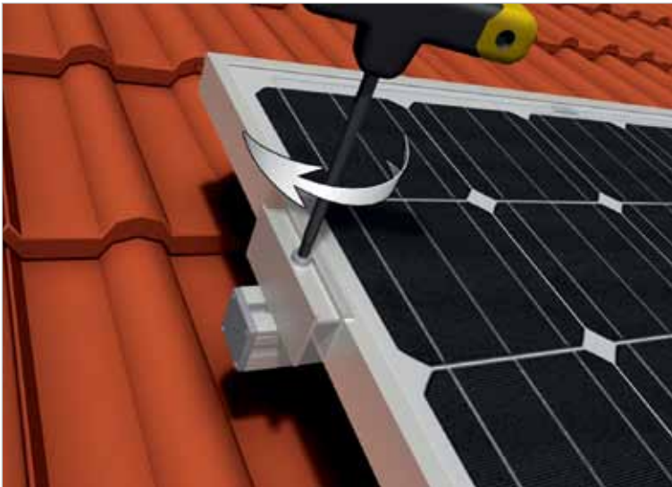
13 - Fixation par vis des brides de terminaison
