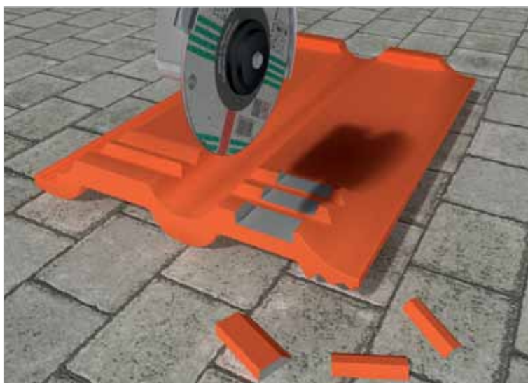
4 - Modification des tuiles
