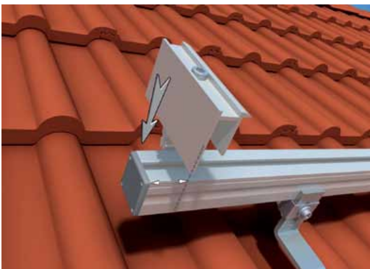
11 - Mise en place des capuchons
