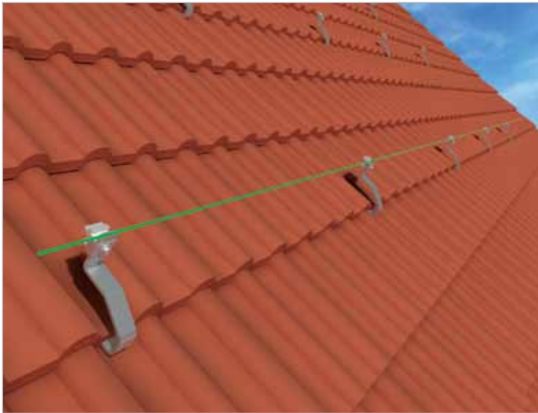
5 - Alignement du crochet de toit
