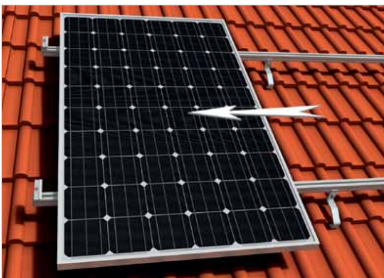
12 - Positionnement du module
