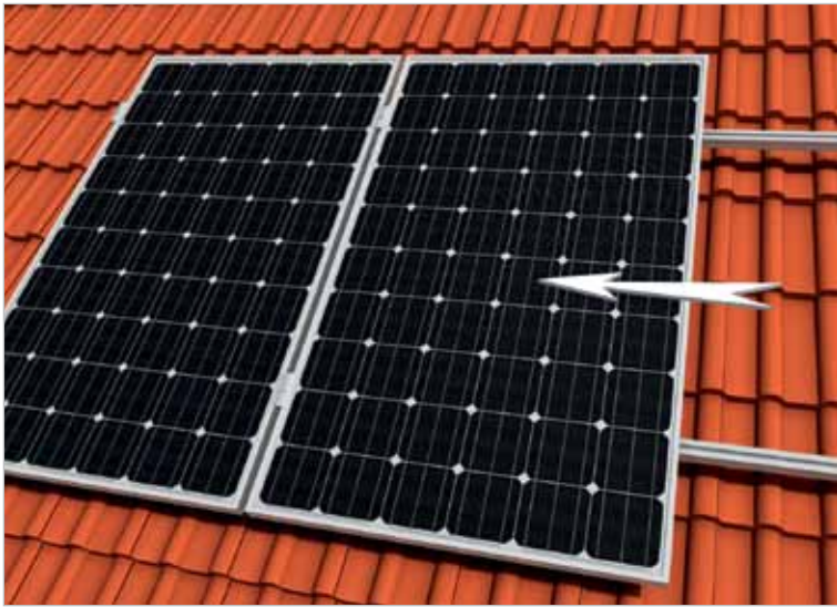
16 - Positionnement des modules
